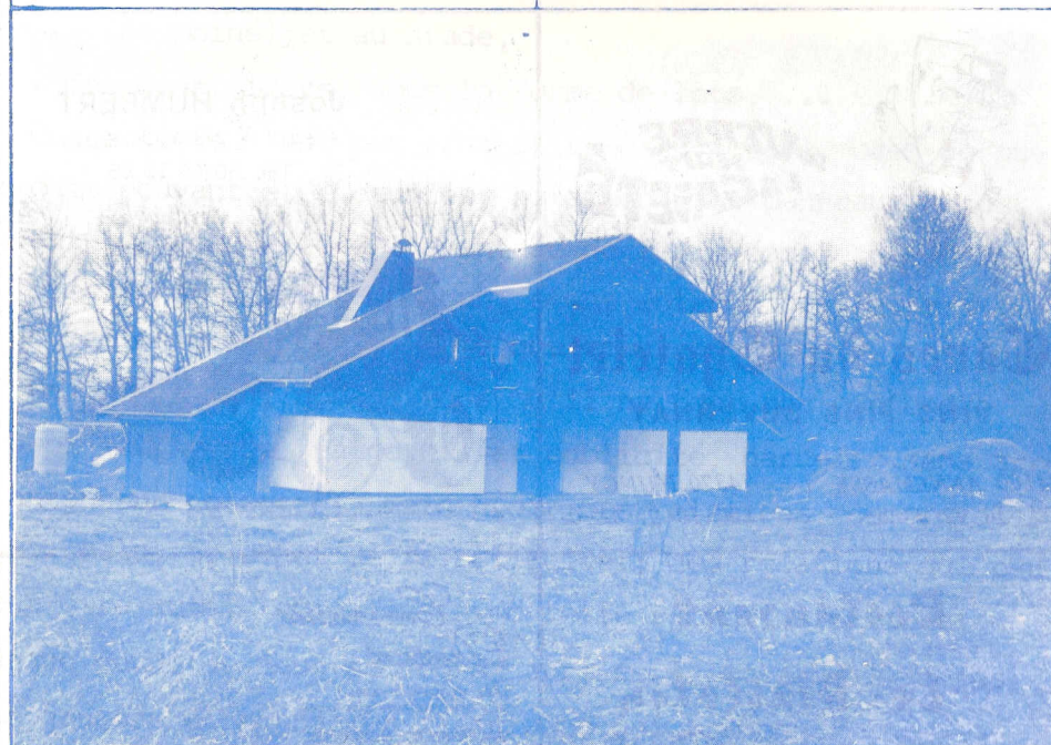
Construction des Vestiaires MARS 1982
